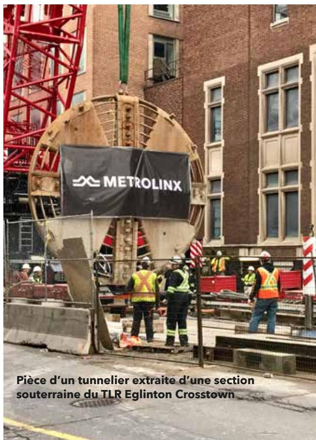
Pièce d'un tunnelier extraite d'une section souterraine du TLR Eglinton Crosstown
