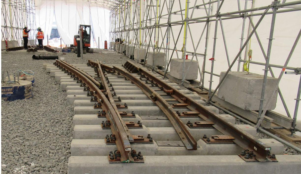
Photo : Installation de rails de TLR en acier sous la tente pour protéger du froid.
