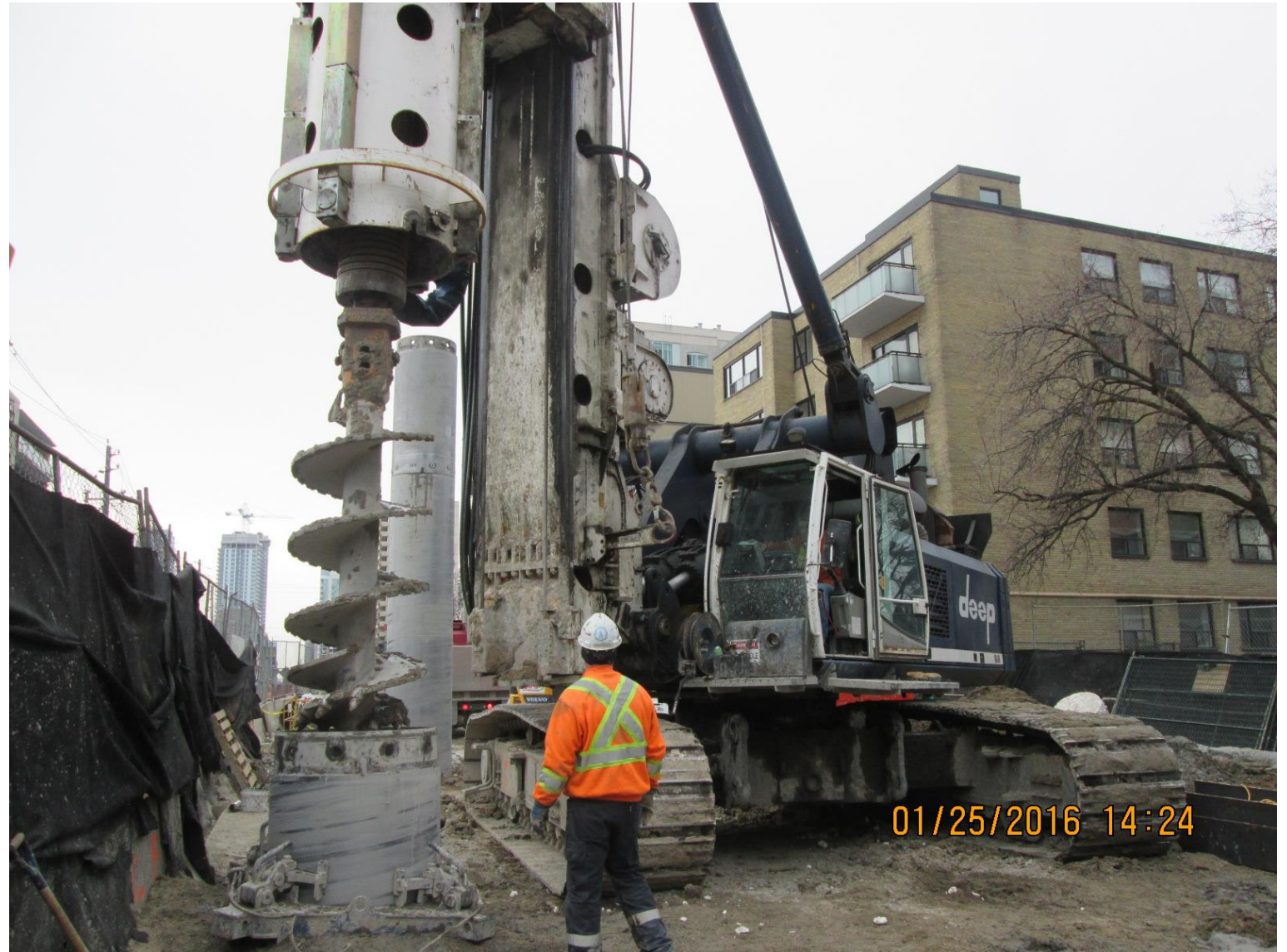
Aecon/Dragados a construit des murs de tête pour le contrat du tunnel Est d'Eglinton Crosstown.
