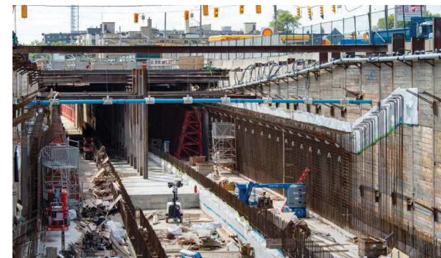
Vue des travaux à l'intersection de Kennedy et d'Eglinton, avec le coffrage destiné au coulage du béton.
