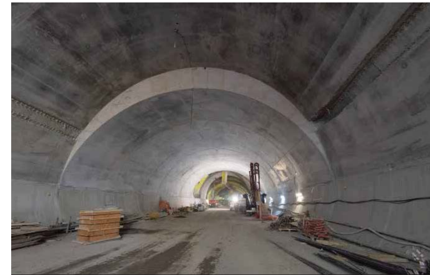
Forage de la gare Laird. On voit les sections terminées du sol et de la voûte.
