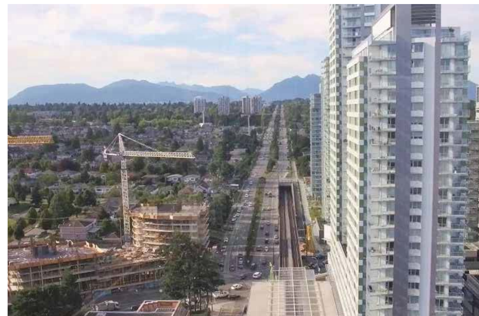
Embouchure du tunnel, Canada Line (Vancouver)
