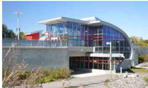
Transitway d'Ottawa : Station de Queensway (haut), station de Longfield (bas).
