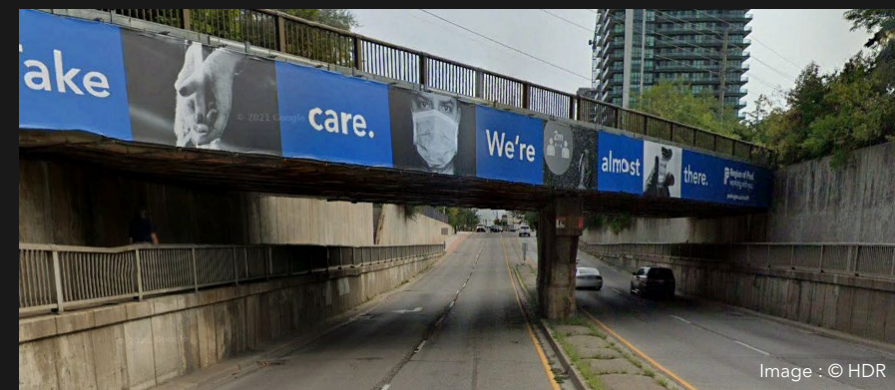
Passage inférieur du couloir Kitchener-Georgetown du Réseau ferroviaire GO
