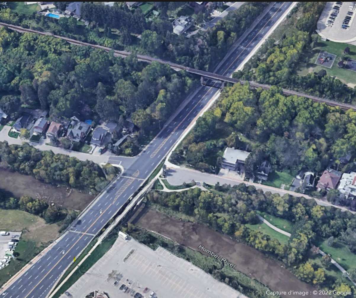
Vue aérienne de la rivière Humber et du passage inférieur du réseau ferroviaire du CP
