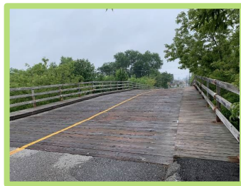
Pont de la rue Albert
