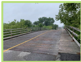
Pont de la rue Albert
