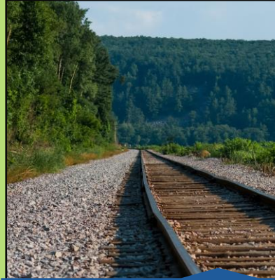
Trackbed Grading (Aug 2022)
