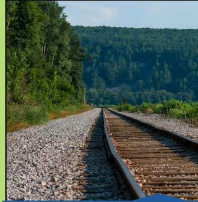
Trackbed Grading (Aug 2022)
