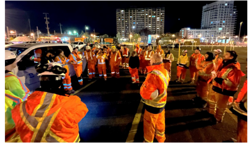
L'entrepreneur général dirige les séances d'information sur la sécurité au travail conformément aux dispositions de Metrolinx.
