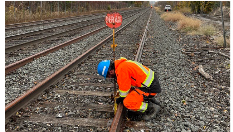
A&B rail installe un dérailleur portable conformément à la protection CROR-841.
