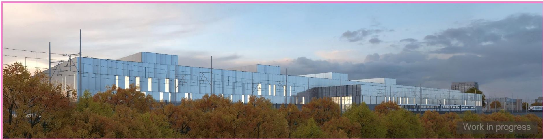
Bâtiment principal - crépuscule. Vue vers le nord depuis le couloir hydroélectrique.
