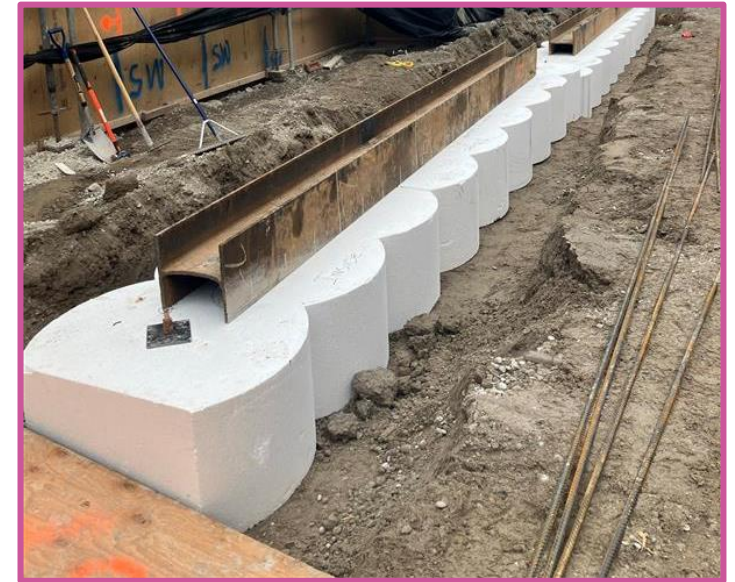
Exemple typique de l'installation de la paroi de guidage pour aligner correctement les pieux sécants pour l'installation.
