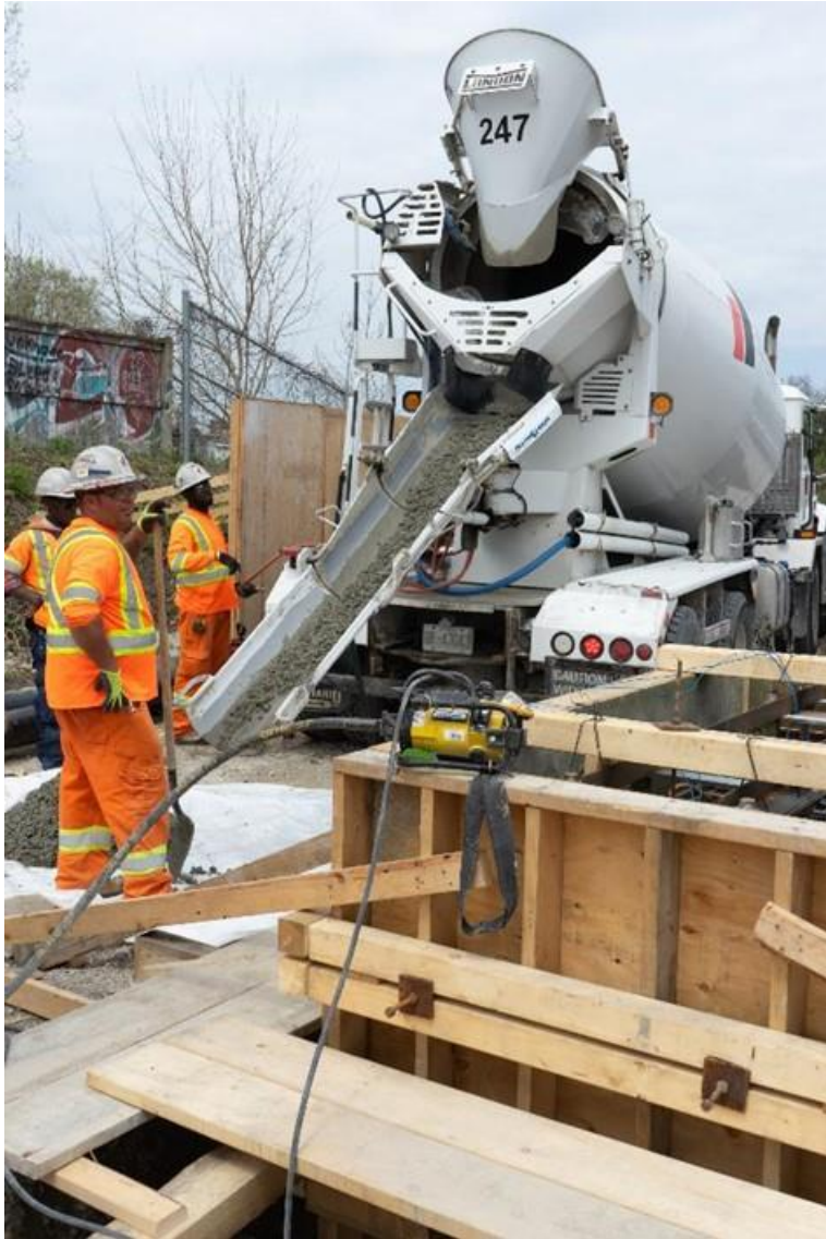
Inspecting the concrete before the big pour
