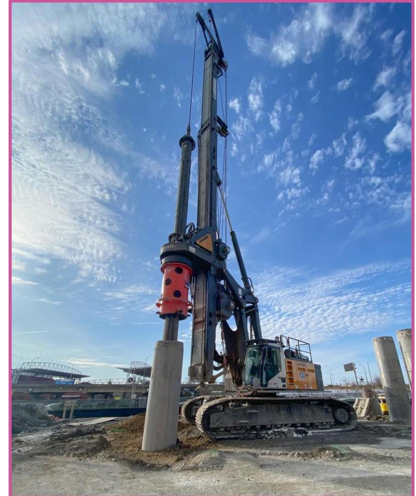
Une machine de forage utilisée dans le cadre du projet de la ligne Ontario pour l'empilage.
