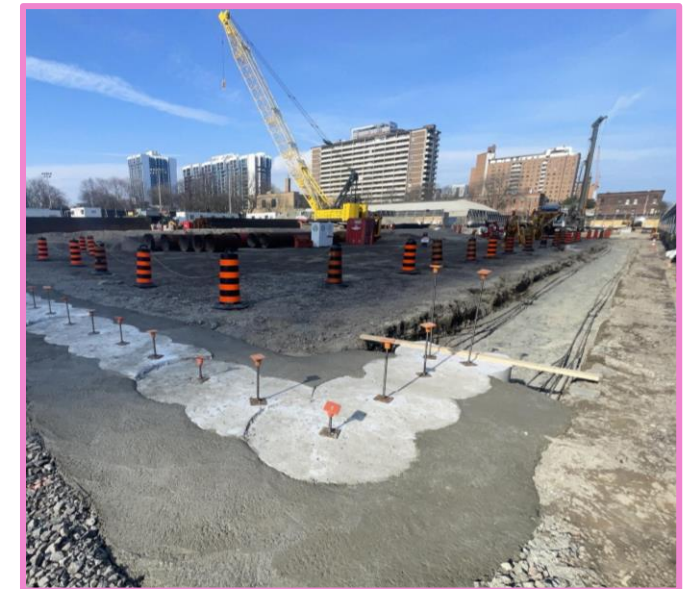
Exemple typique de l'installation du mur de guidage pour aligner correctement les pieux sécants
