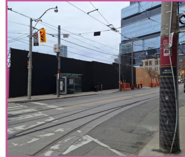
Exemple de palissade/mur antibruit de 5 mètres de hauteur
