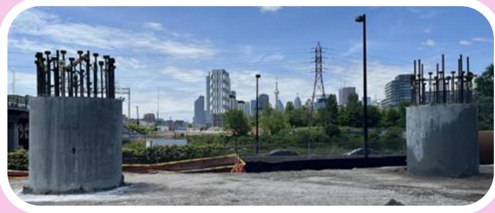
Commencer les travaux permanents pour la culée du pont à l'est du Don Valley Parkway. La culée est une structure en béton de **15,7 m** de longueur x **3,15 m** de largeur x **3,5 m** de hauteur
