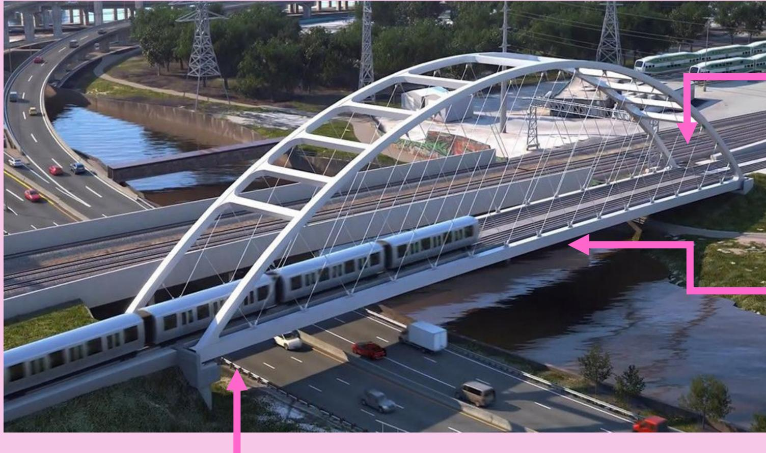
**Plateforme du pont :** La plateforme est la surface du pont qui repose sur les culées. La nouvelle ligne de métro Ontario circulera sur le dessus de la plateforme du pont.
