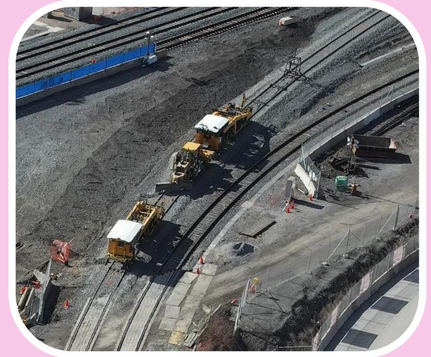
Enlèvement de **1300 m** de voies ferrées anciennes et installation de **1200 m** de nouvelles voies
