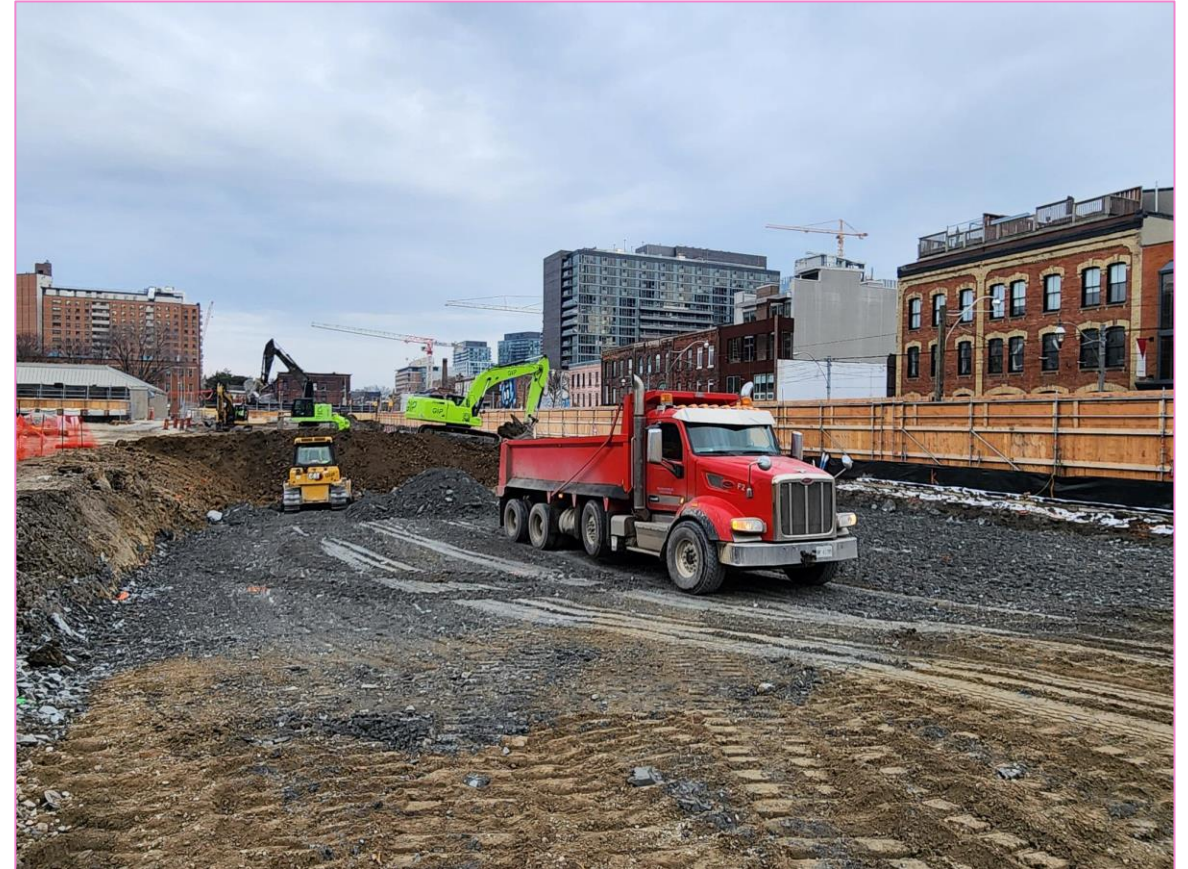
Excavation du quai de travail au stade initial
