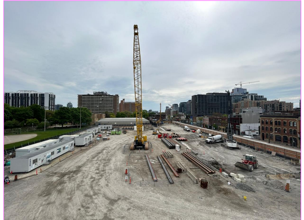
Vue vers l'est sur les poutres en H
