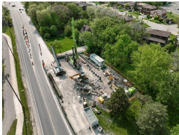
Bâtiment de sortie de secours n° 2 (chemin Russell)
