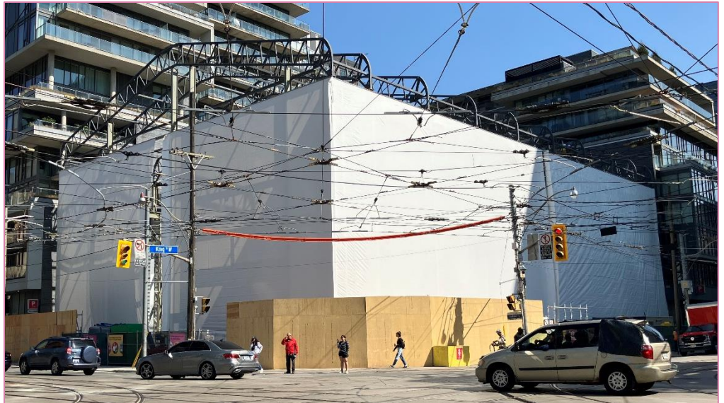
Abri acoustique du site nord de King-Bathurst, où auront lieu les travaux d'excavation.
