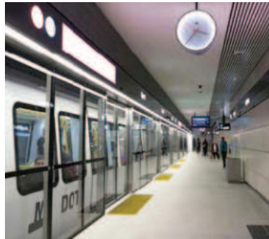
PLATFORM EDGE DOORS
