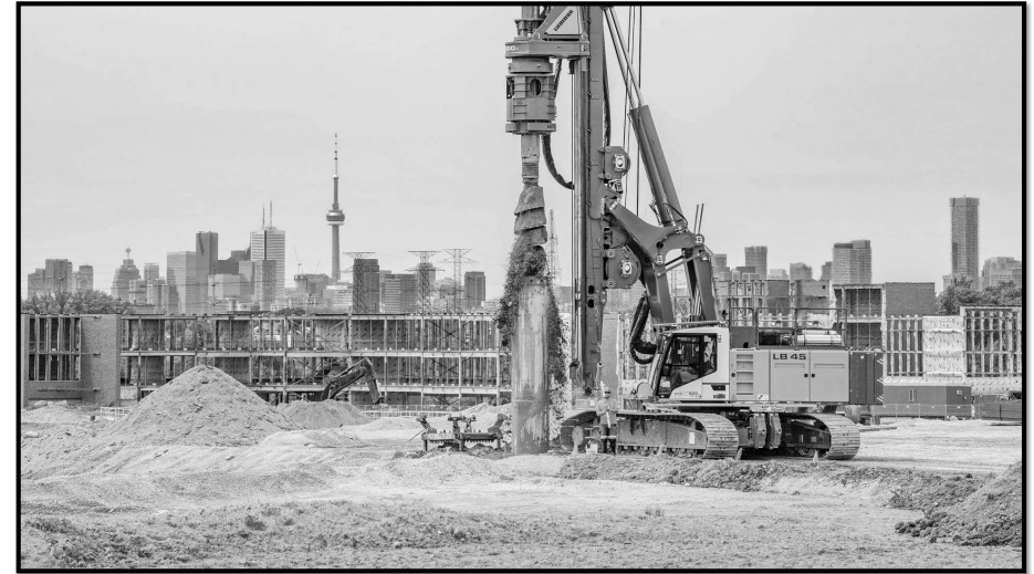
Exemple de fondation sur puits bétonnés Source : Groupe Liebherr
