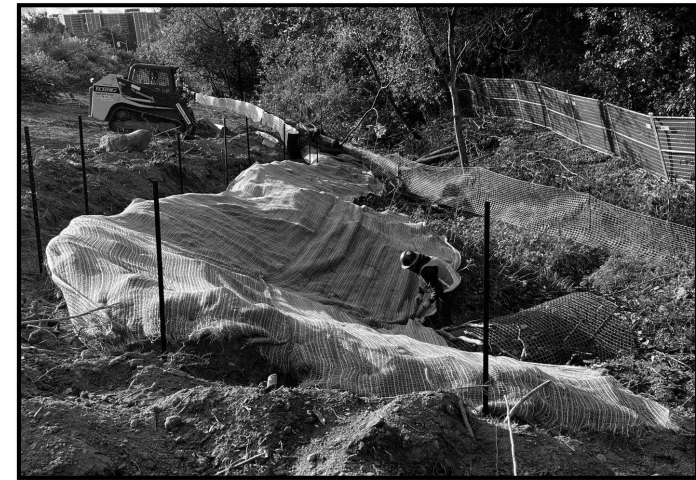
Des couvertures de contrôle de l'érosion étant installées sur le site des travaux de construction de la voie de guidage.
