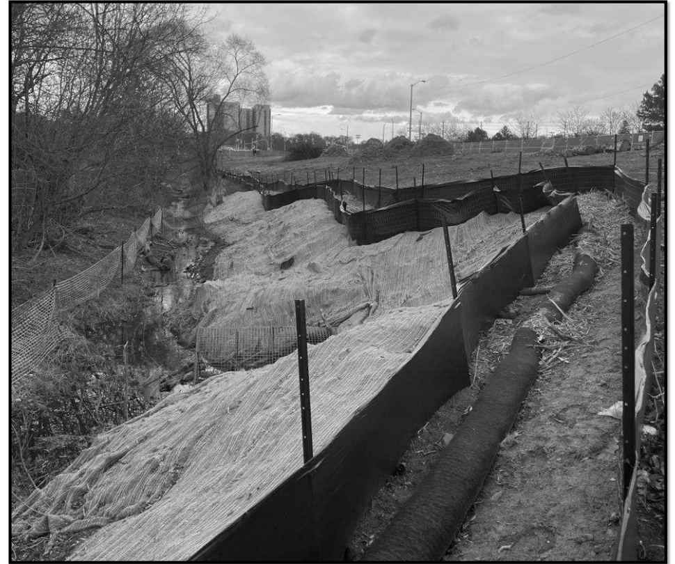
Clôture anti-érosion double au site de construction de la voie de guidage élevée
