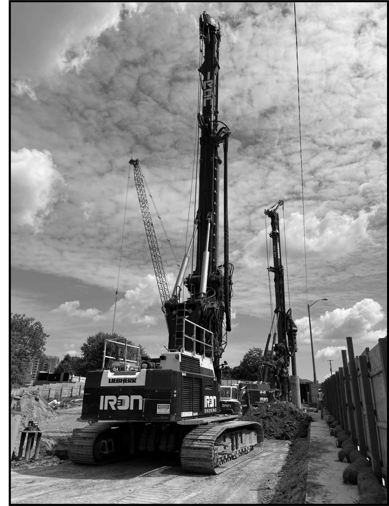
Machine à percer utilisée dans la construction de pieux
