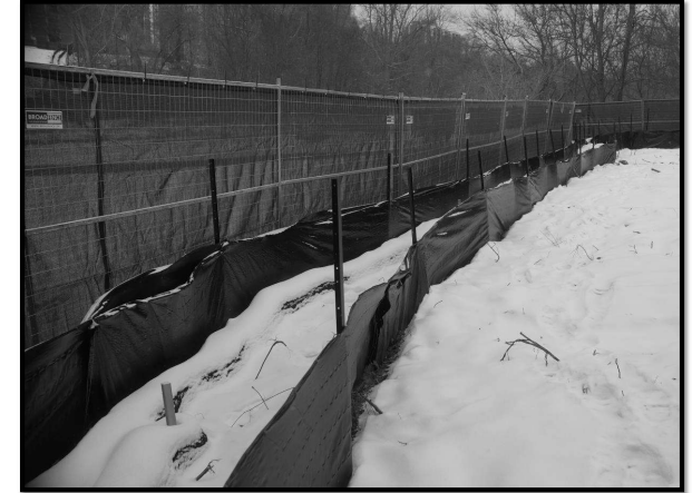
Clôture anti-érosion double au site de construction de la voie de guidage élevée
