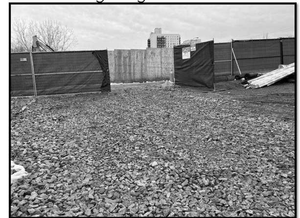
Tapis de protection sur le site de construction de la voie de guidage surélevée.
