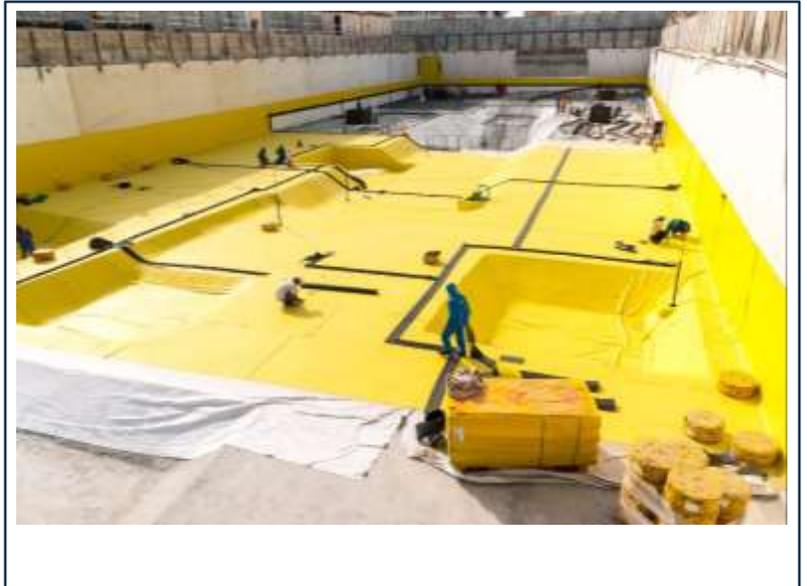
Exemple d'installation d'un système d'étanchéité
