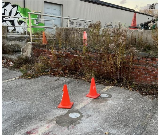
Figure 1 : Exemples d'instruments de surveillance lors de l'installation. Après l'installation, les couvertures des instruments sont à niveau avec le sol et les cônes sont retirés.
