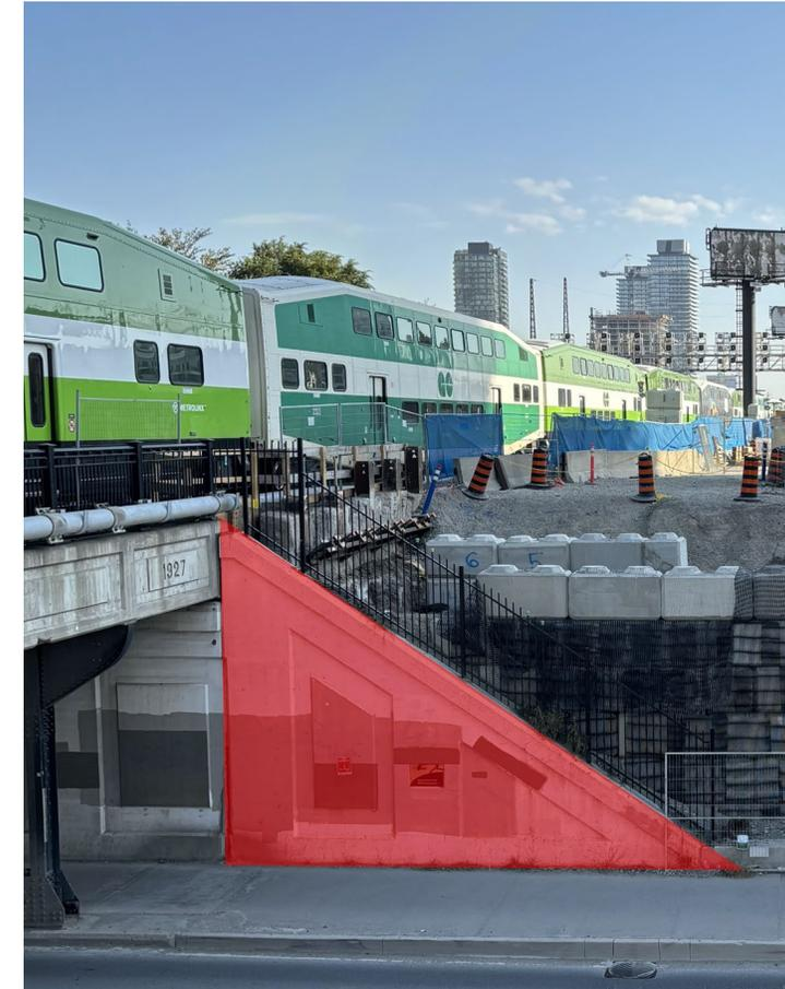
Photo : Mur de soutènement
