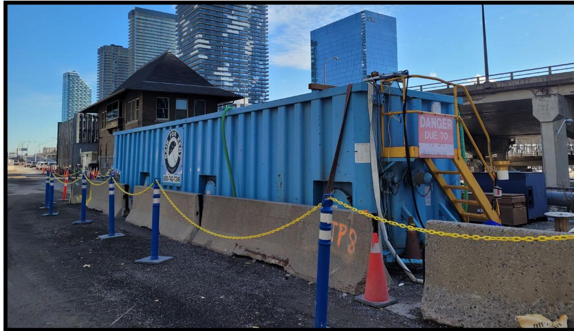
Cuves de rétention pour le système d'assèchement des travaux de construction situées près de la tour Scott.
