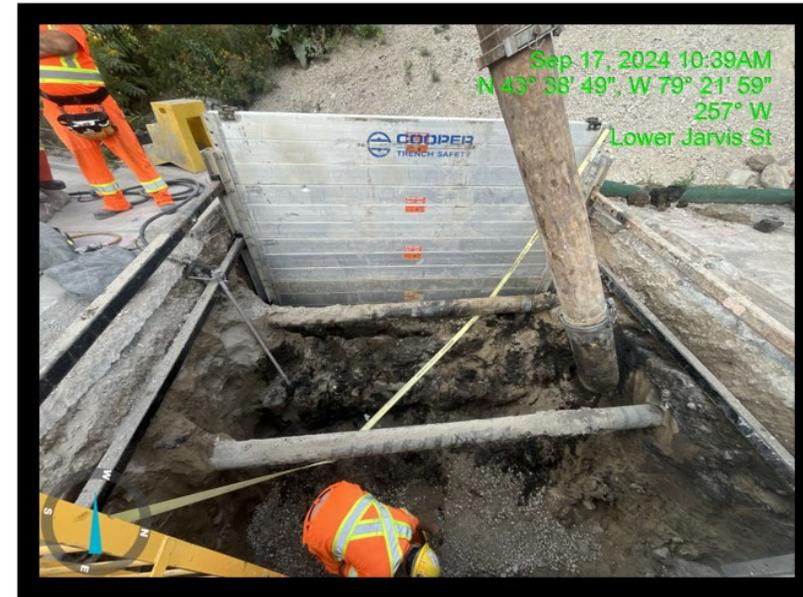
Bois de charpente découvert lors de l'excavation par aspiration hydraulique à la rue Lower Sherbourne West.
