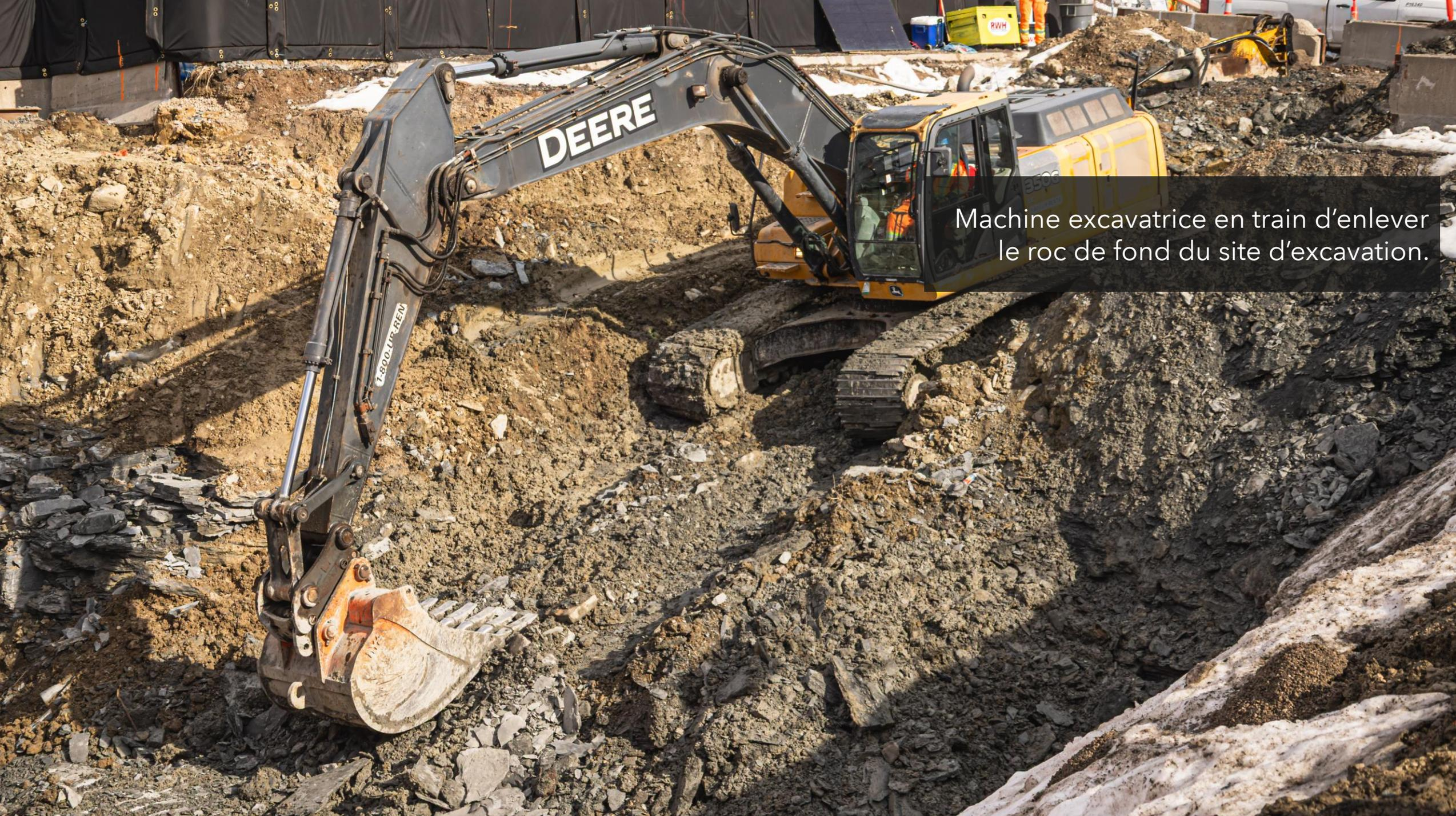
Machine excavatrice en train d'enlever le roc de fond du site d'excavation.
