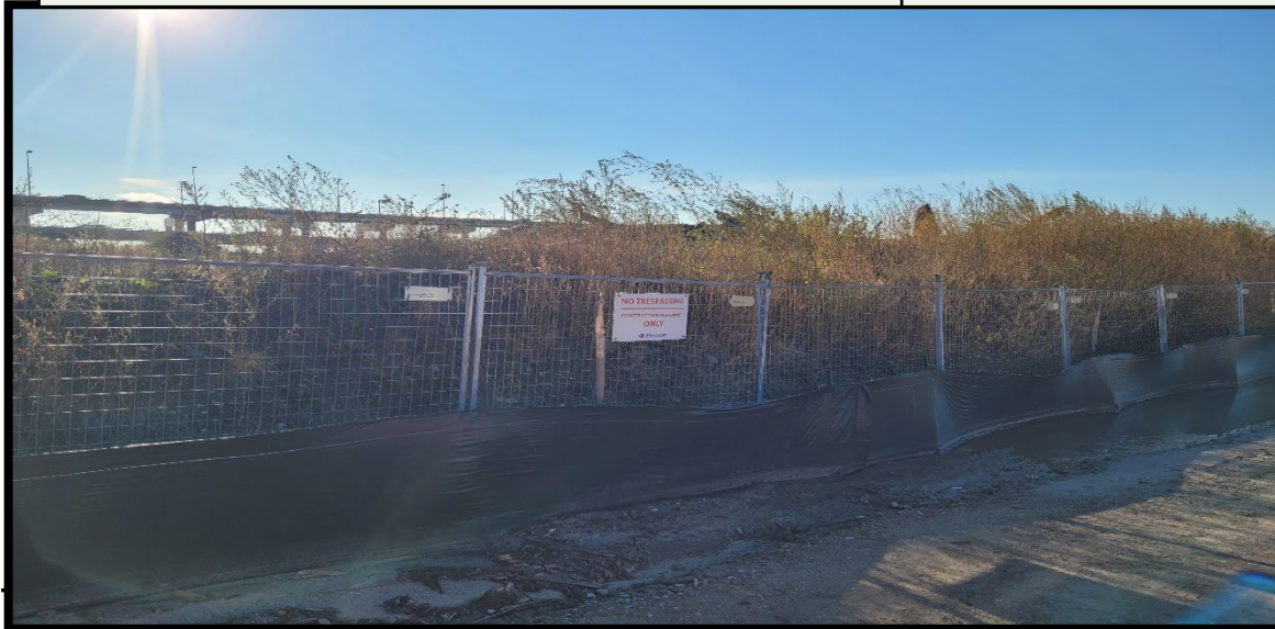
Érosion et contrôle des sédiments à la gare de triage Wilson
