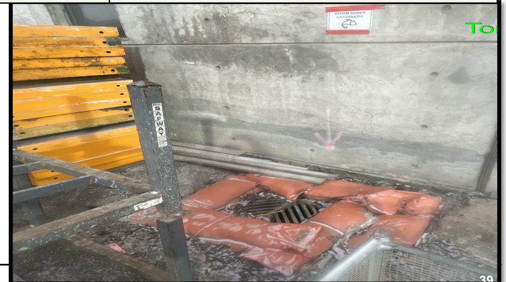
Bouche d'égout avec barrière de sacs de sable
