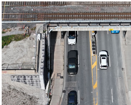
Installation d'un mur sécant
