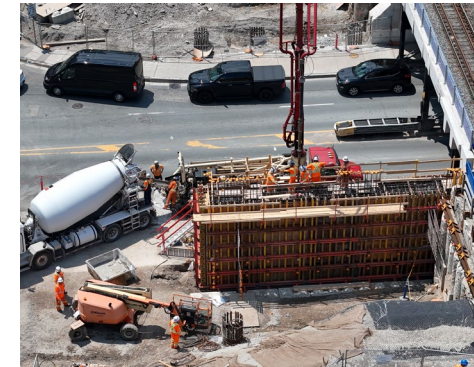
Coulage de béton pour les nouvelles culées aux deux emplacements du pont.
