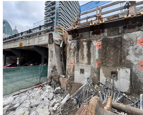
Démolition de l'ancienne paroi de rive et la façade du pont
