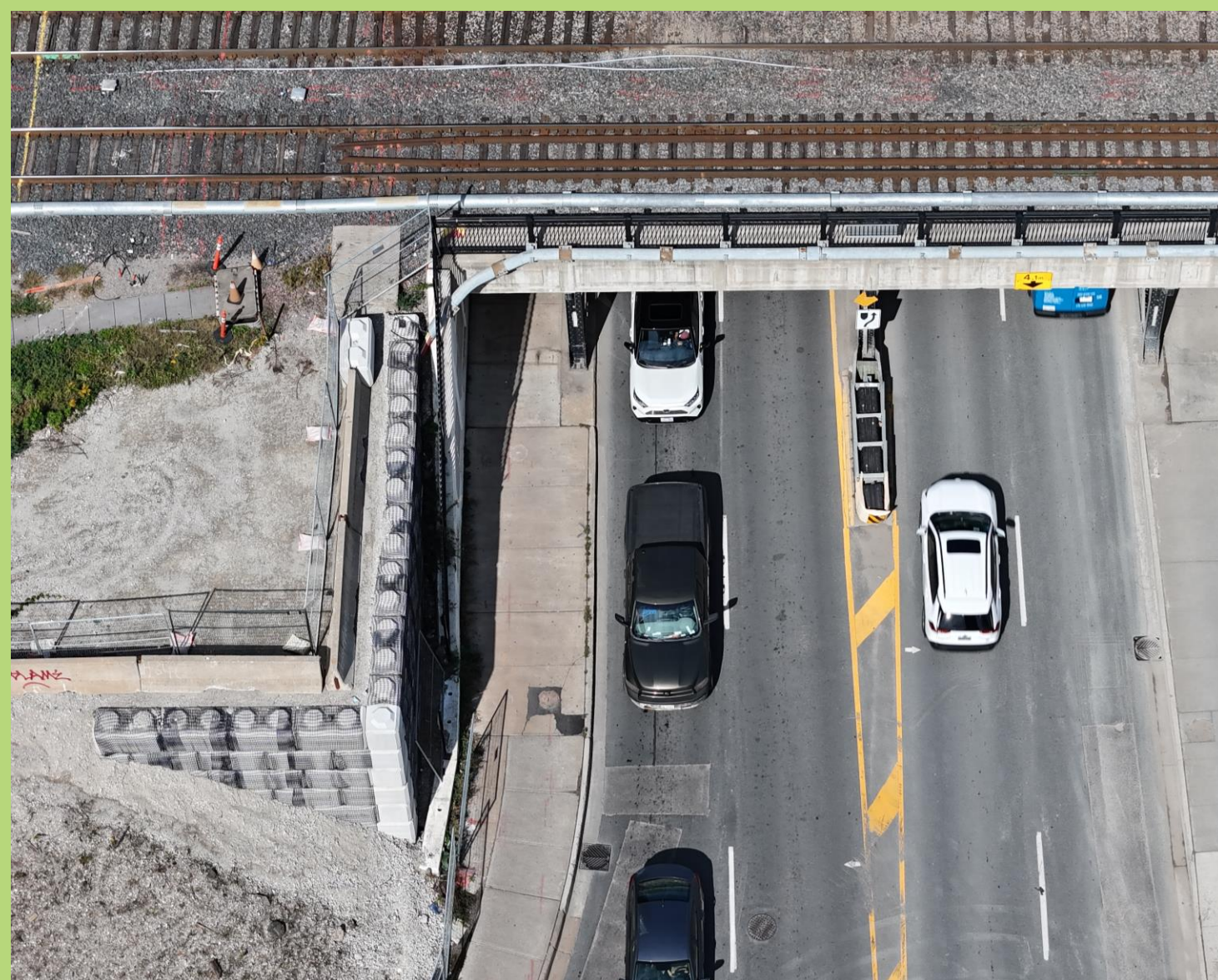
Mur sécant installé
