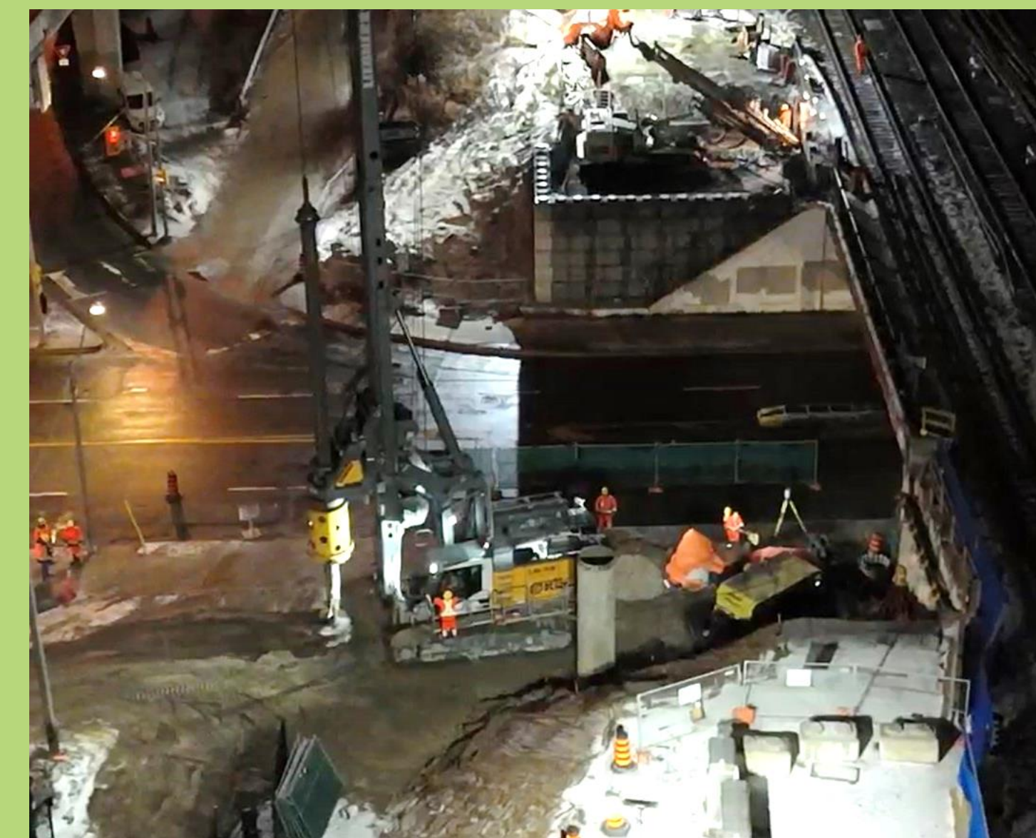
Installation d'une nouvelle fondation à caissons
