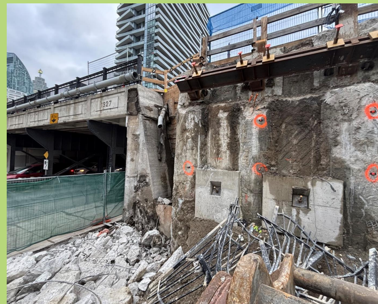
Ancien mur de soutènement et façade du pont démolis
