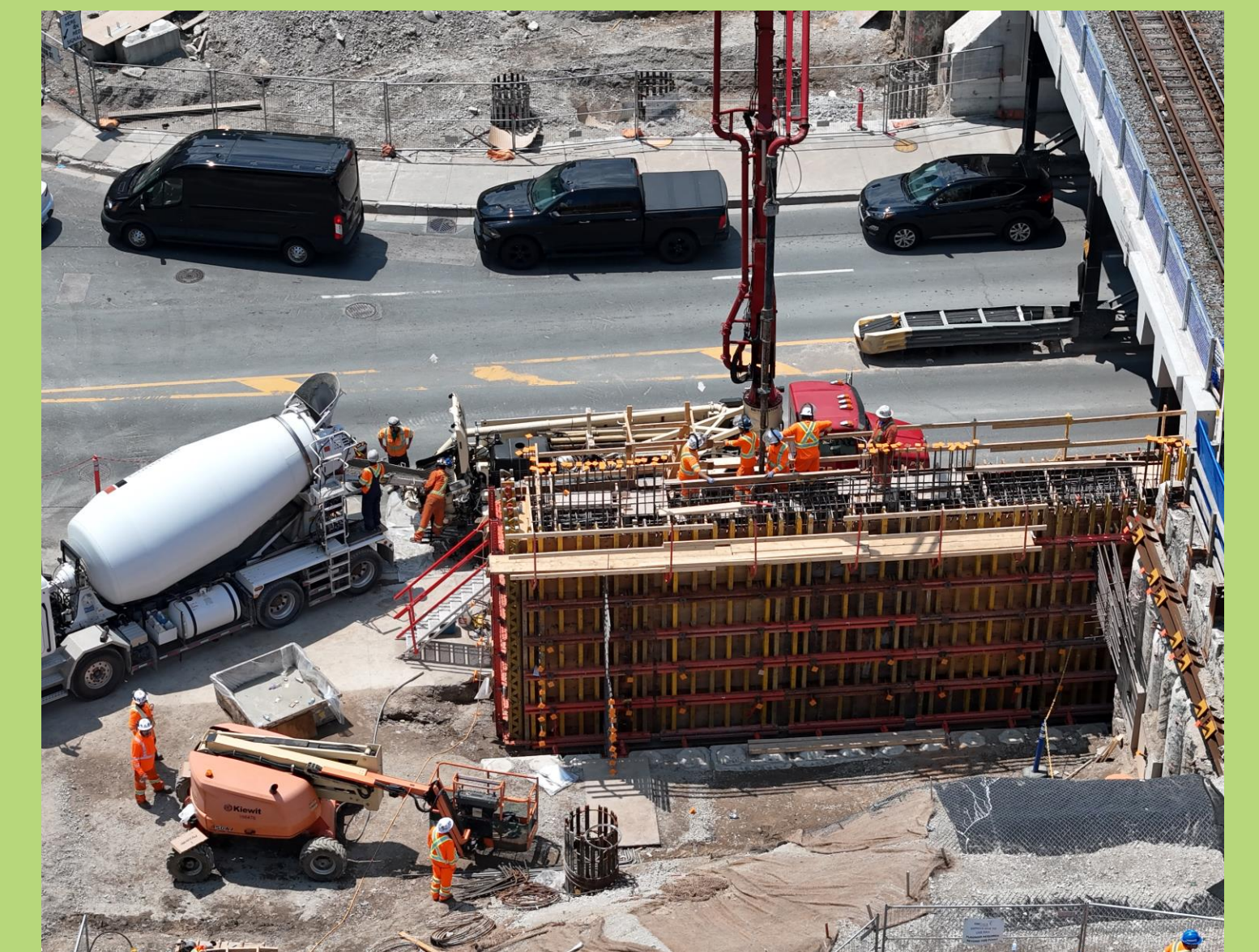
Béton coulé pour les nouvelles culées aux deux emplacements du pont.
