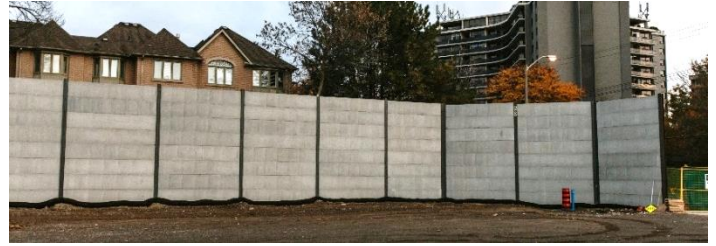
Mur antibruit au chantier sur le chemin Roval
