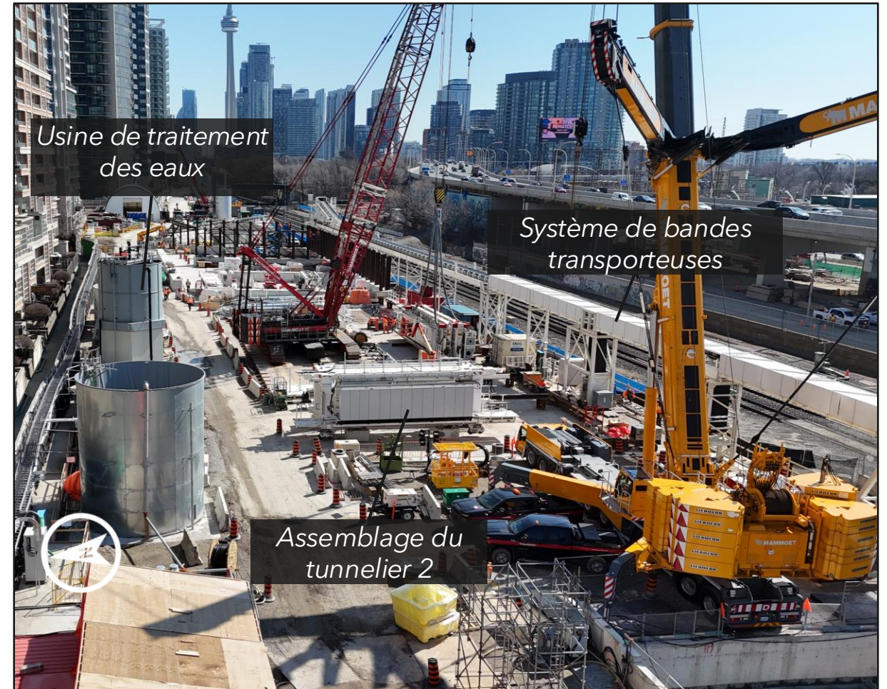
Une vue de la zone d'assemblage du tunnelier et des structures d'exploitation du creusement de tunnels.
