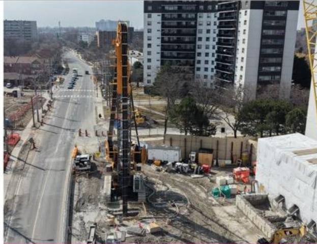
Construction de fondations solides
