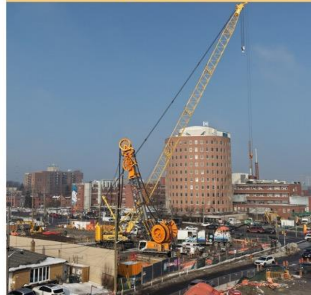
Construction de la station Lawrence et McCowan
