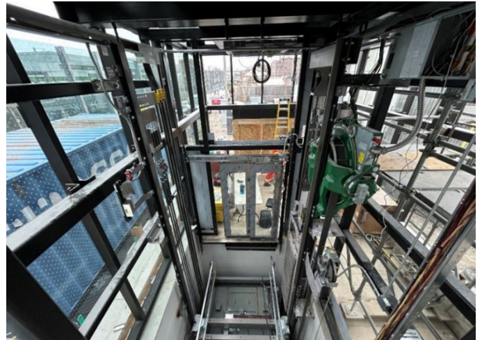
Figure 3 : Puits d'ascenseur du pavillon piétonnier
