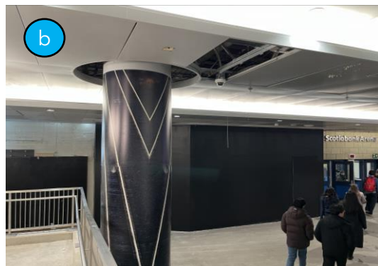
Vue de Bay Arcade (Faisant face au sud)
