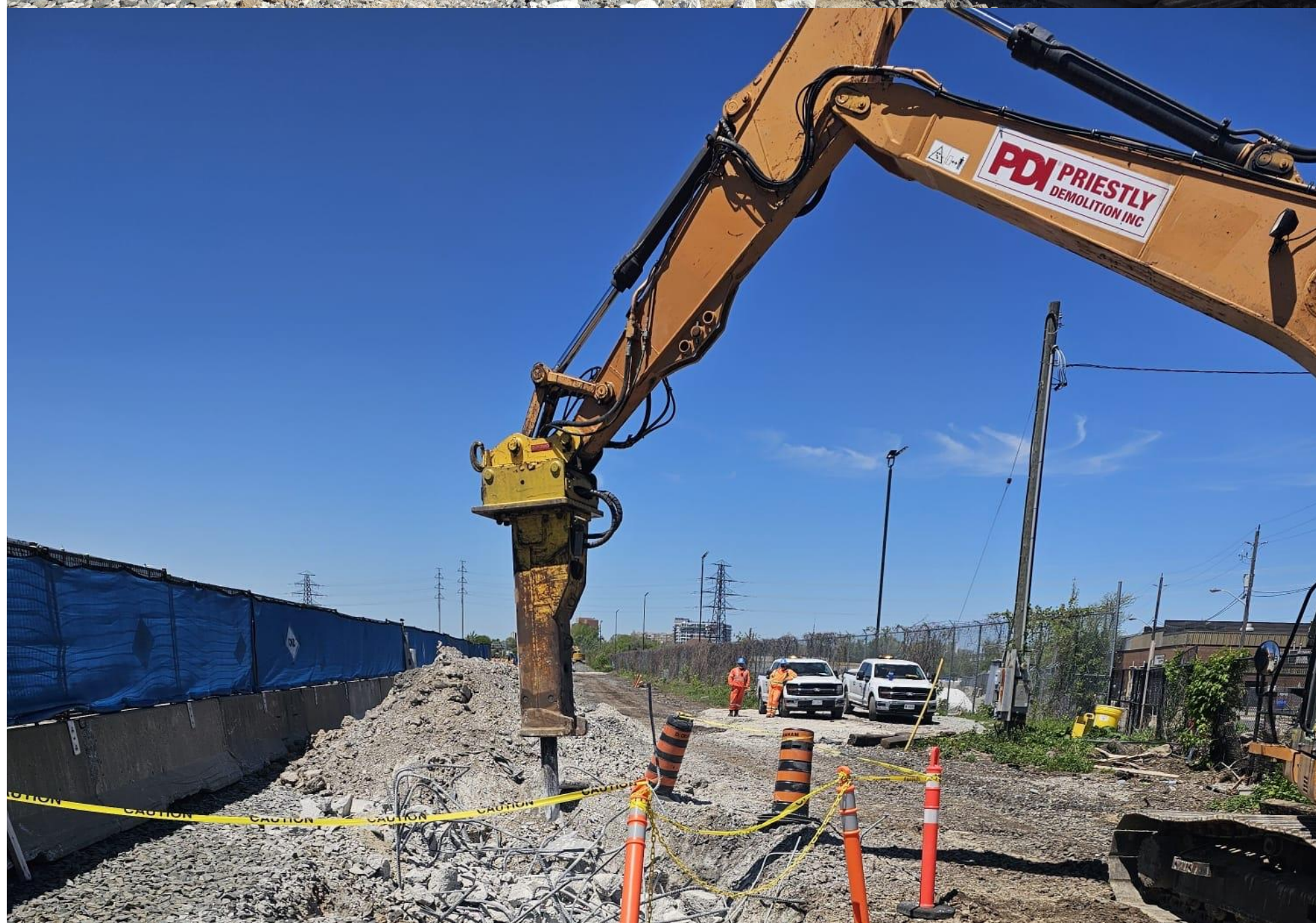
Démolition du mur de soutènement et des fondations du portique de signalisation (dans le
