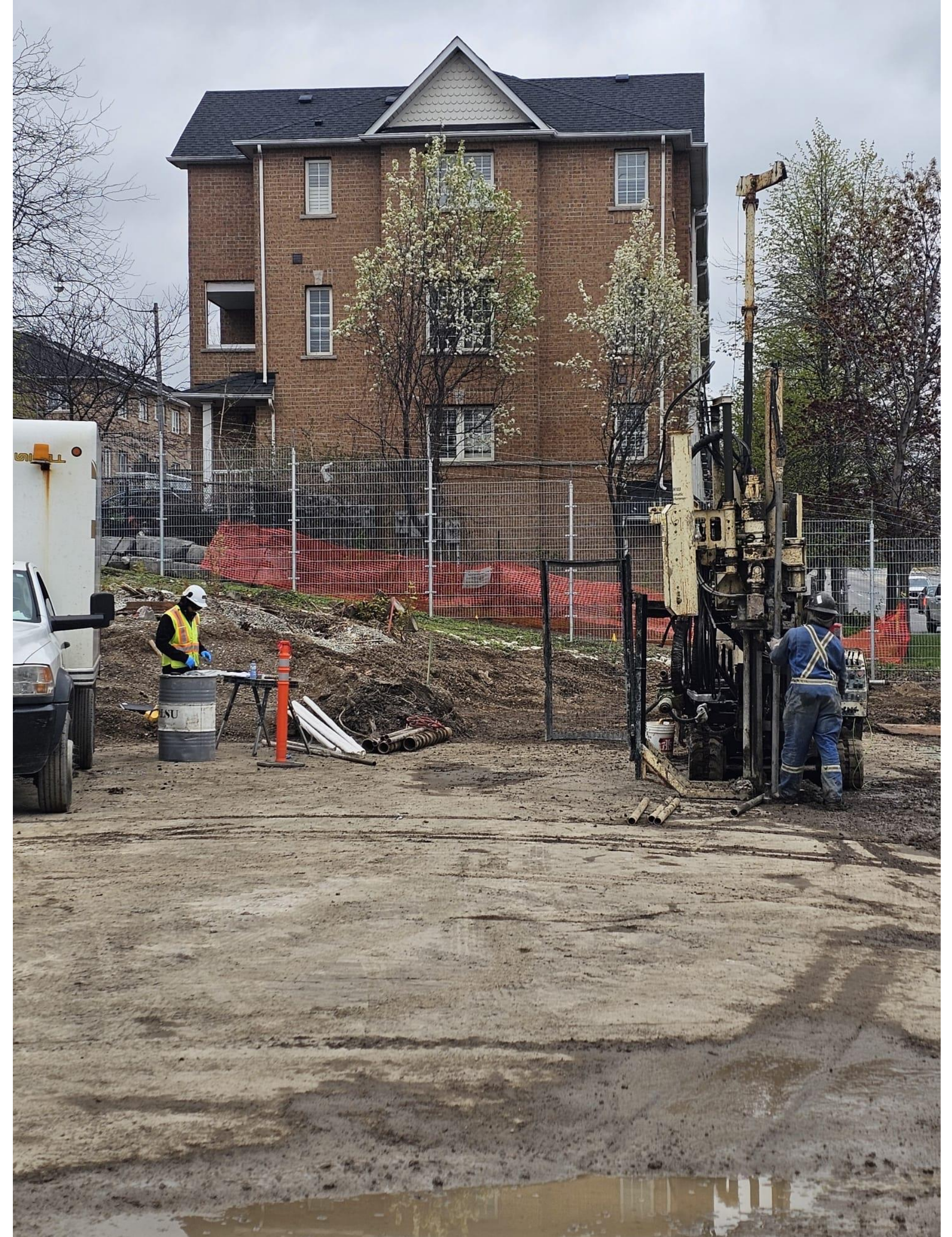
Forages environnementaux et travaux de dépôt au 153, chemin Weston
