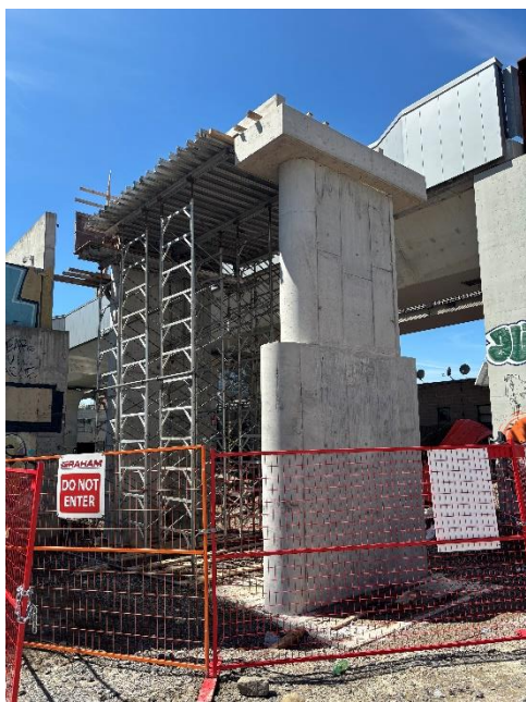
#1 Travaux de rampe en lacet (nord services Landing) et travaux sur le pont piétonnier
