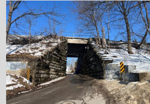
Pont ferroviaire de la rue McNabb
