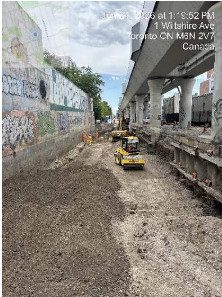
Rampe en lacet n° 1 Remblayage de fondation
