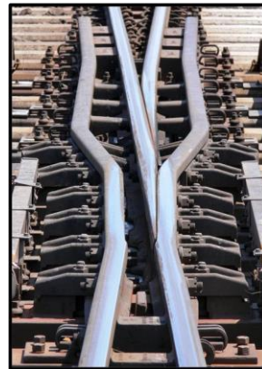
Les pointes de cœur mobiles éliminent l'écart entre les rails aux croisements, réduisant le bruit et les vibrations causés par les trains passant sur ces croisements
