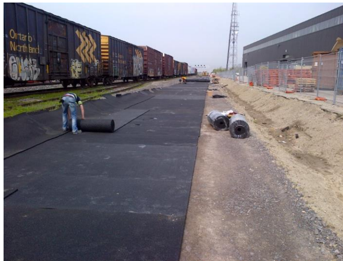
Exemple d'installation de tapis de ballast
