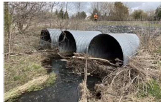
Ponceau du TAO à triple compartiment
