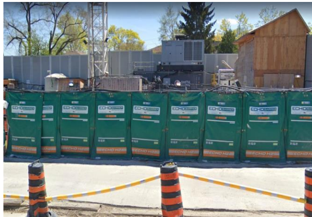
Exemple de barrière mobile insonorisante de chantier.
