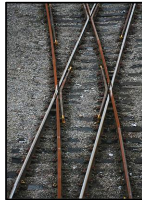
Croisement standard ou grenouille montrant des espaces entre les rails qui génèrent un bruit et une vibration supplémentaires
