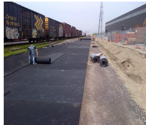
Exemple d'installation de tapis de ballast
