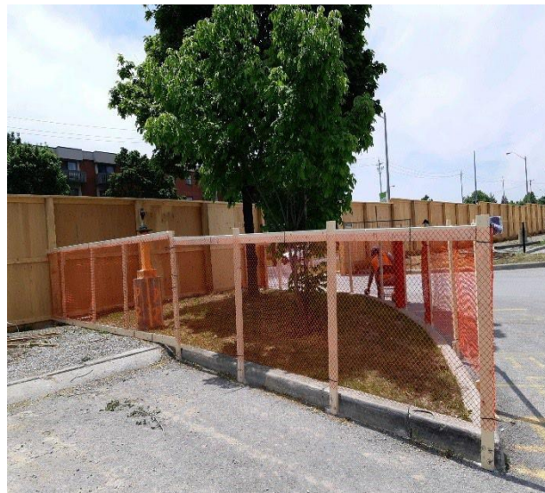
Exemple de clôture de protection des arbres.
