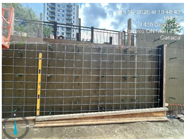
Renforcement du mur du trottoir Dupont
