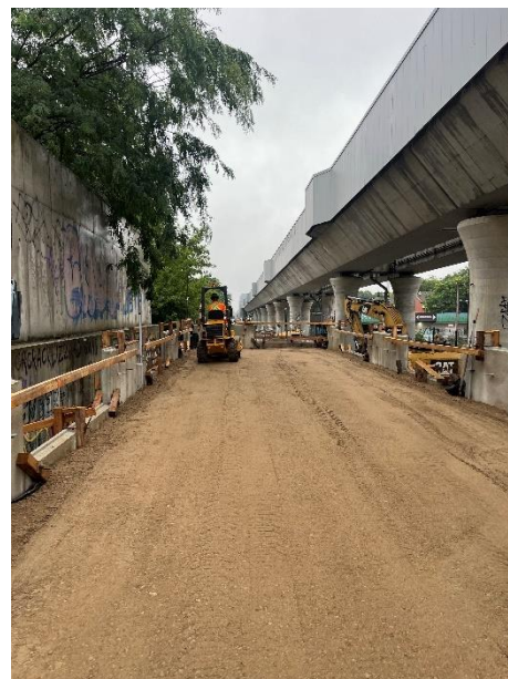
Structure de rampe en lacet terminée à 50 %
