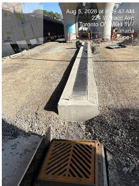
Installation du drain de la terminée au tranchée nord de Wallace
